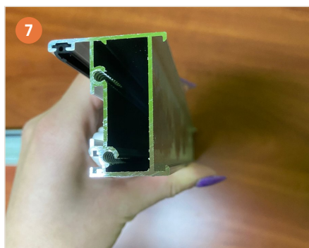
7 Montant vu en bout : les canaux de vissage.
