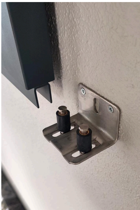
Figure 5 – Guidage à doubles olives sur équerre réglable, vissé au mur ; en haut à gauche, le bas du volet et son profilé en U
