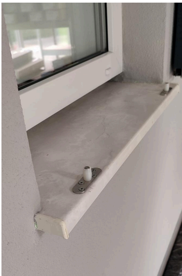
Figure 4 — Guidages à olive simple vissés sur un appui de fenêtre : un à chaque bout de l'appui
