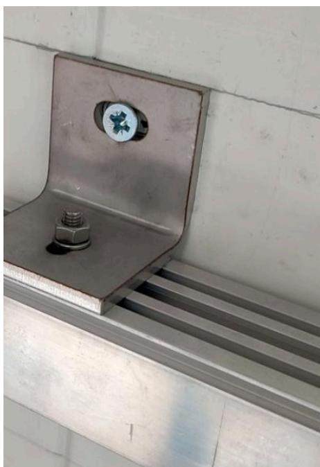
Figure 1 — Une équerre de fixation : vissée au mur par son trou oblong, boulonnée sur une rainure du dessus du rail
