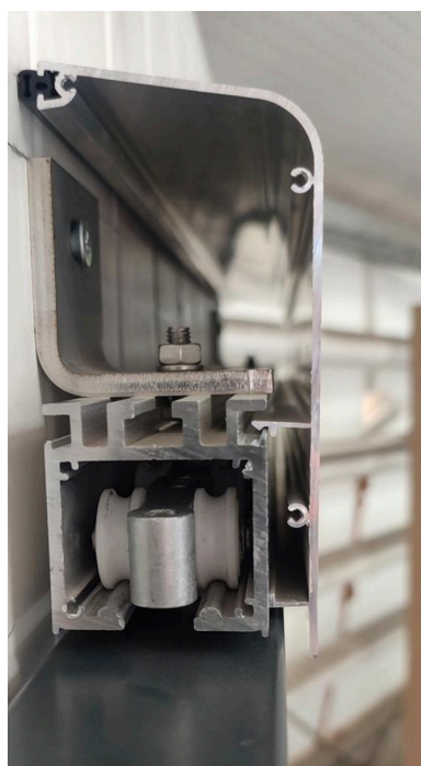
Figure 3 — Le rail posé, vu en bout : le chariot et ses deux galets dans le rail, le volet suspendu dessous
