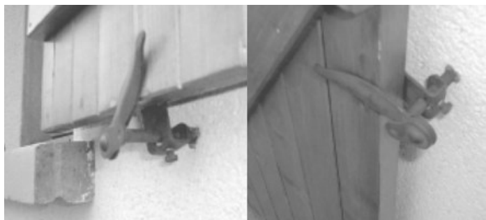
Figure 9 – Deux modèles d'arrêts à visser, une fois posés
