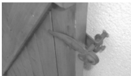
Figure 14 — Un arrêt à tourniquet fixé à la façade, qui retient un vantail ouvert
