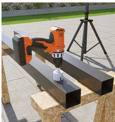
Figure 13 — Étape 11 — le perçage du poteau à la scie cloche de 80 mm
