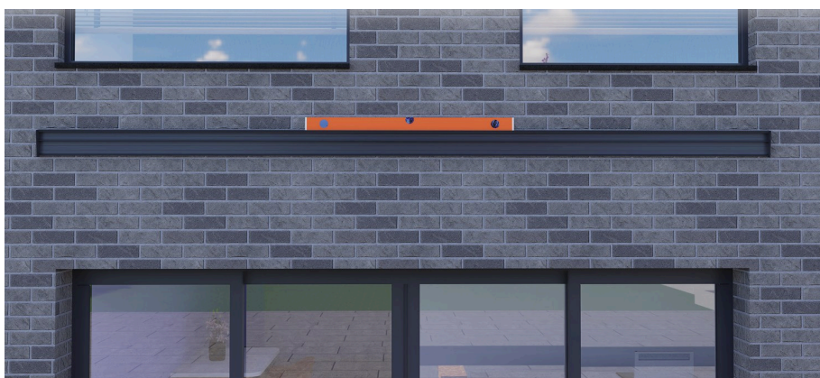
Figure 7 — Étape 5 — le profil mural présenté sur la façade et réglé de niveau
