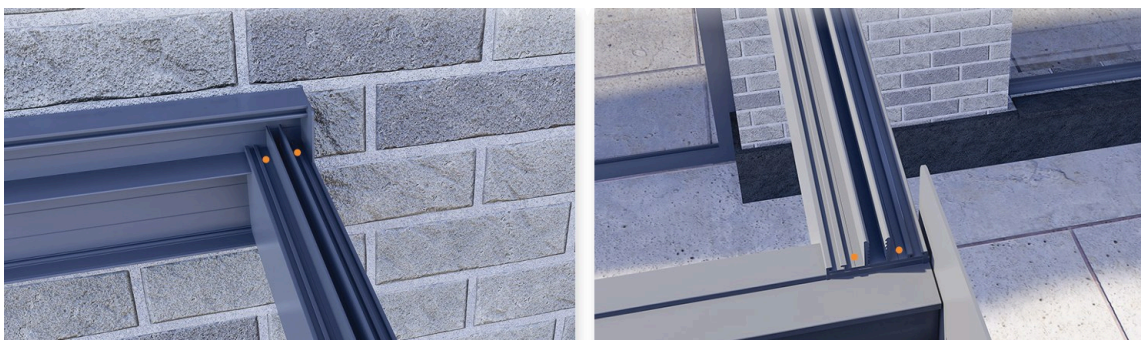
Figure 11 – Étape 9 – le chevron de rive vissé sur le profil mural (à gauche) et sur le chéneau (à droite)
