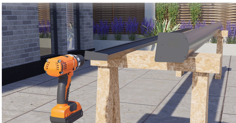
Figure 4 — Étape 2 — l'embout du profil mural (au premier plan) ; derrière, le chéneau et son embout
