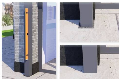
Figure 30 – Étape E – l'aplomb du poteau arrière, le béton coulé, le carreau reposé
