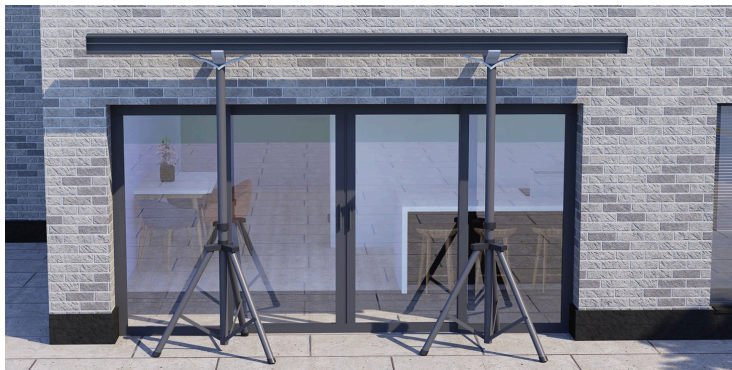
Figure 28 – Étape C – le tube de renfort et son profil mural, posés sur deux trépieds
