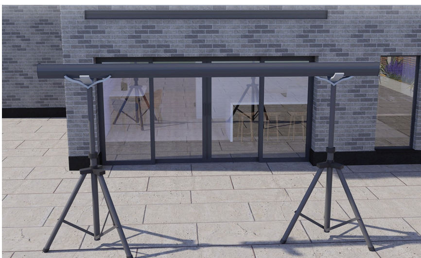
Figure 10 – Étape 8 – le chéneau posé sur deux trépieds, face au profil mural
