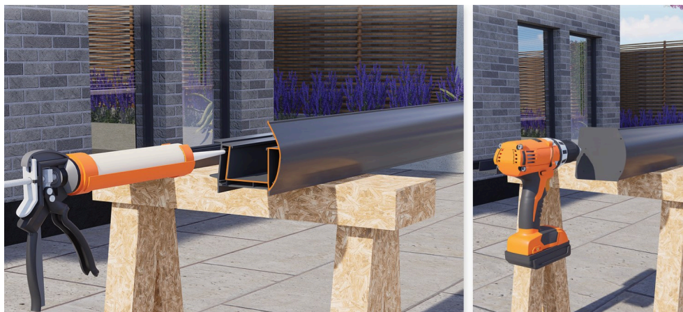
Figure 3 — Étape 1 — le mastic sur la tranche du chéneau, puis l'embout arrondi vissé
