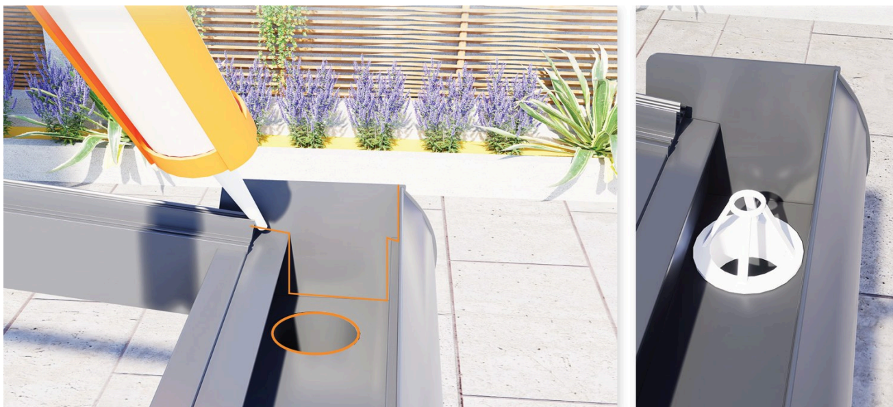
Figure 19 — Étape 17 — le mastic le long de l'embout et autour de la sortie d'eau, puis le collecteur de feuilles en place
