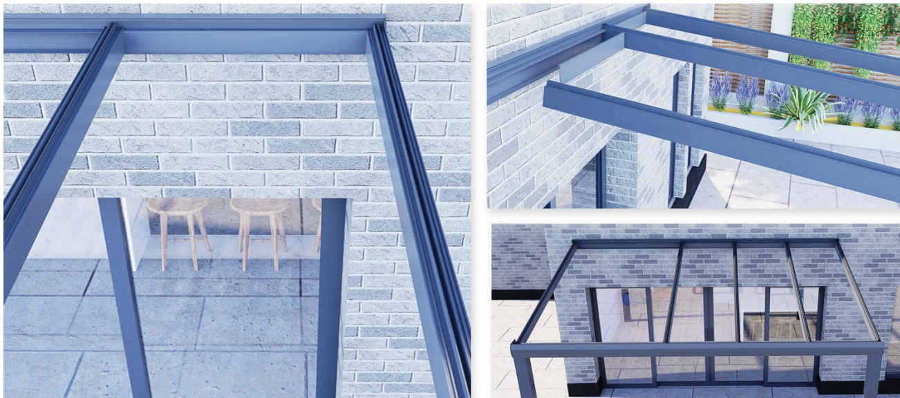
Figure 20 — Étape 18 — les caches décoratifs entre les chevrons, côté profil mural et côté chéneau ; à droite, tous les chevrons posés
