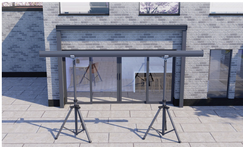
Figure 31 – Pose autoportante, étape 8 – le chéneau sur ses trépieds, face au tube de renfort porté par les poteaux arrière
