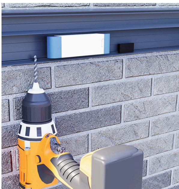
Figure 21 — Étape 19 — le transformateur des spots LED logé dans le profil mural, et le trou du câble
