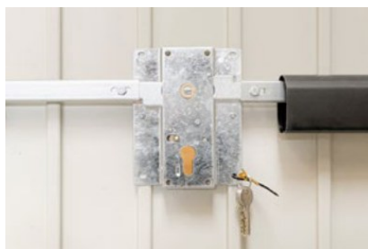
Figure 5 — La serrure 2 points latéraux, vue de l'intérieur du garage
