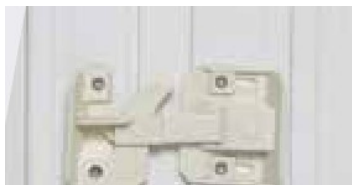
Jalousie PVC : le loquet, sur les deux lames du centre.
