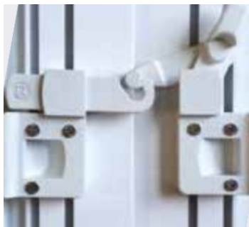
Jalousie aluminium : le loquet tendeur, sur les deux vantaux du centre.
