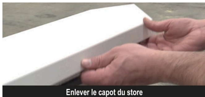
Figure 3 – Le capot à enlever, puis le store à retourner
