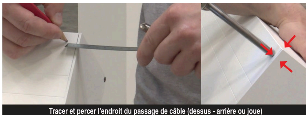
Figure 4 – Le tracé et le perçage du passage du câble ; à droite, le trajet du câble dans le coffre
