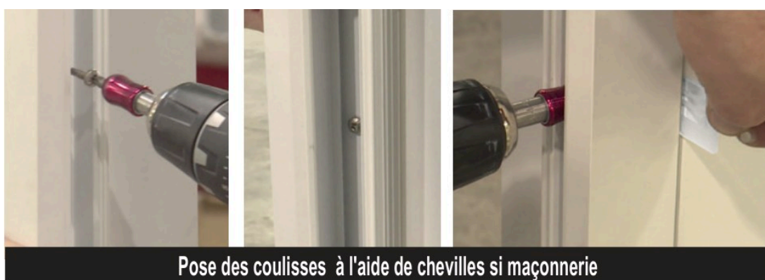
Figure 12 — La fixation d'une coulisse par le côté
