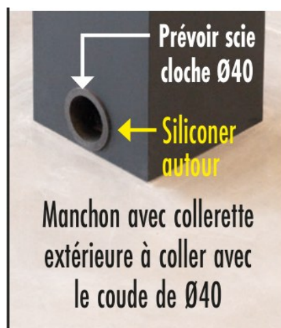
Figure 51 — Le manchon à collerette se colle avec le coude ; siliconer autour
