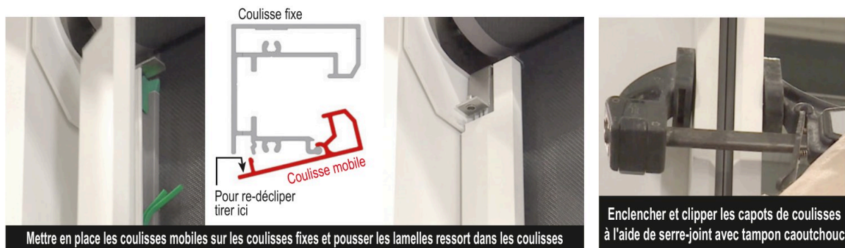
Figure 70 — La coulisse mobile clippée sur la coulisse fixe
