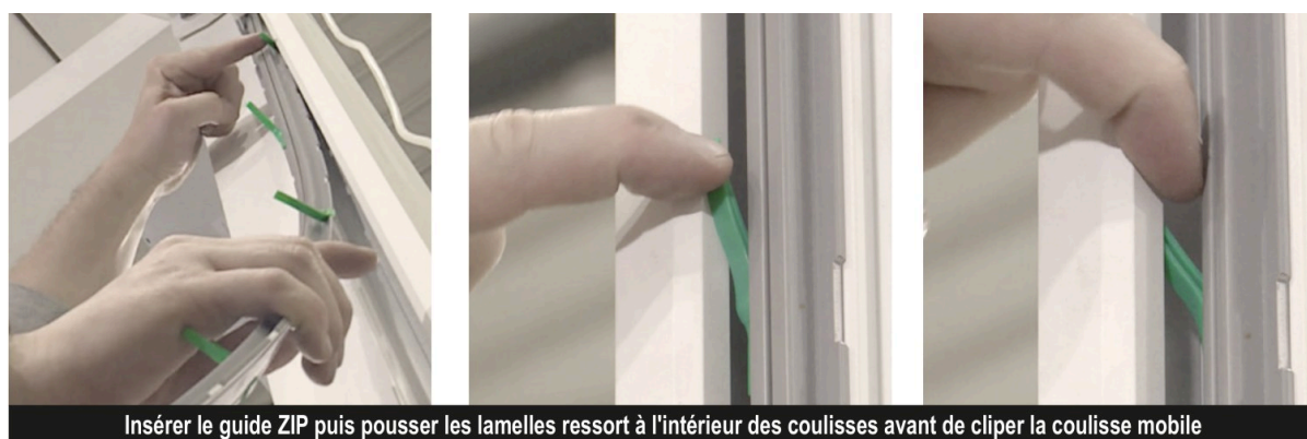
Figure 69 — Le guide ZIP inséré, les lamelles ressort poussées dans la coulisse
