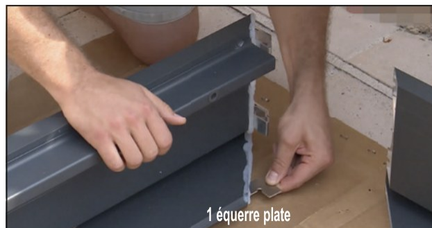
Figure 10 — L'équerre plate
