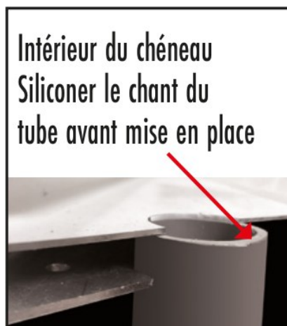
Figure 47 — En haut : le tube dans le chéneau, son chant siliconé
