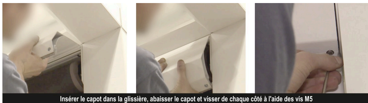
Figure 71 — Le capot du coffre : dans la glissière, abaissé, vissé de chaque côté
