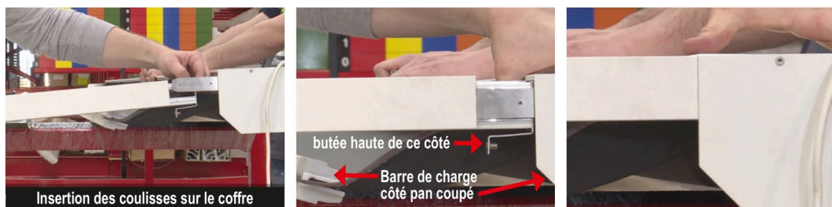
Figure 63 — Les coulisses s'engagent dans les joues du coffre
