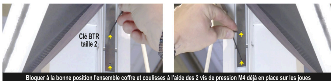
Figure 64 — Les 2 vis de pression de chaque joue, à la clé six pans de 2
