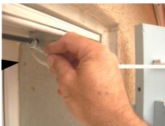
Figure 8 — Tourner le 6 pans de 7 avec une clé de 7
