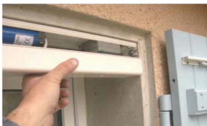
Figure 9 — Le capot clipsé ; le bras remonté et bloqué
