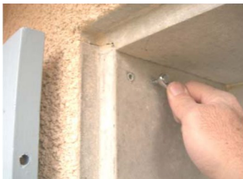
Figure 3 — Le premier tire-fond, pas encore serré
