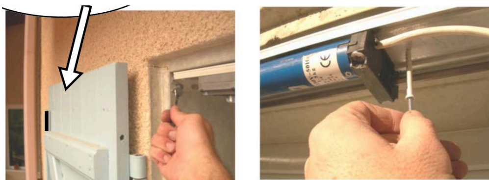
Figure 4 — L'espagnolette raccourcie si besoin ; la fixation centrale d'un caisson long
