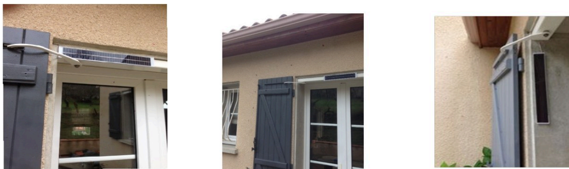
Figure 10 — Façade au soleil : le panneau sur le tableau
