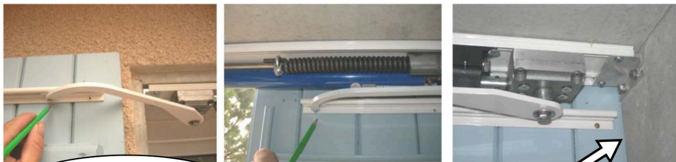
Figure 6 — Tracer la course ; la coulisse en place ; vérifier qu'elle ne touche pas l'angle du mur
